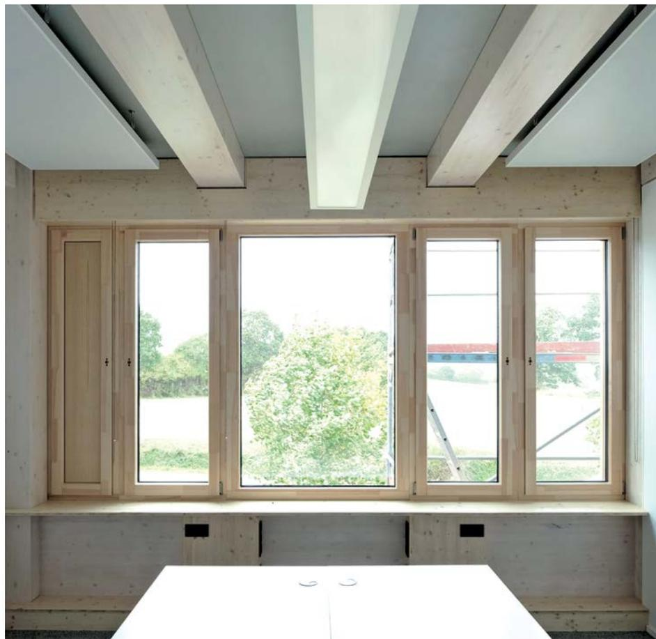
Die Decke über dem 1. OG ist in zwei Bereiche unterteilt: Im Bereich der Büroräume eine Holz-Beton-Verbunddecke. Sie besteht aus Brettschichtholzträgern, im Achsraster von 1,5 m senkrecht zur Fassade angeordnet. Auf diese Holzträger sind Betonfertigteile aufgelegt, die mit Schraubverbindungen zu einem Tragsystem verbunden wurden. Oberhalb der Konstruktionsebene wurden eine Schüttung aus Split, Trittschalldämmung und ein Zementestrich verlegt.
